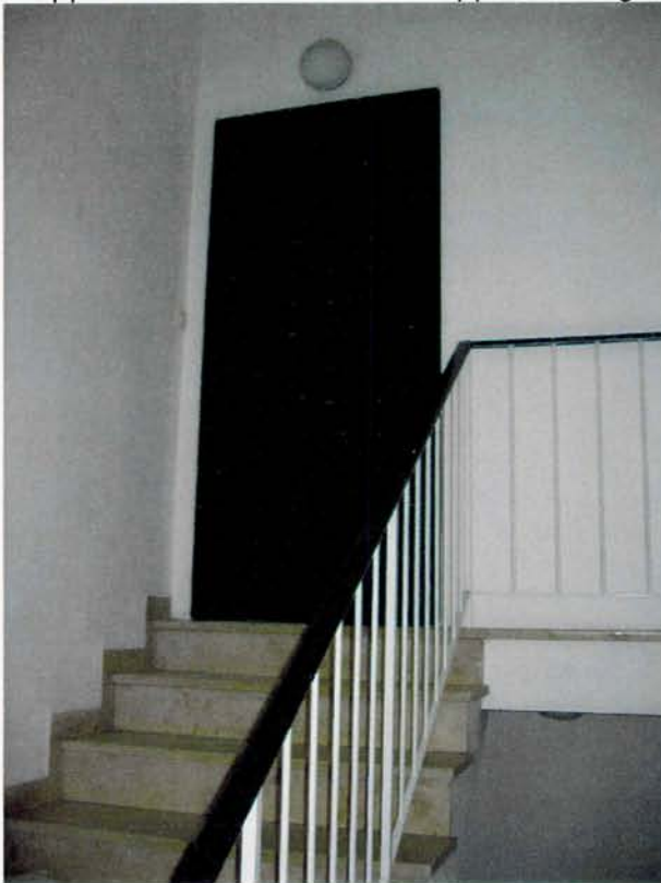
Abbildung 7 Treppenraumseitige Ansicht der Trennwand – mit Spanplattenabschluß der Türöffnung, Treppe ohne Podest am Zugang
