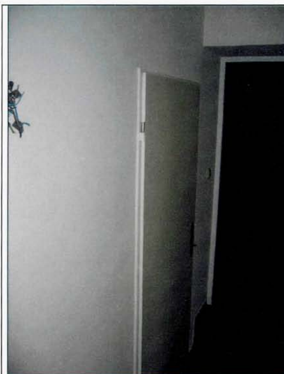
Abbildung 1 Trennwand zum Treppenraum des Rückgebäudes
