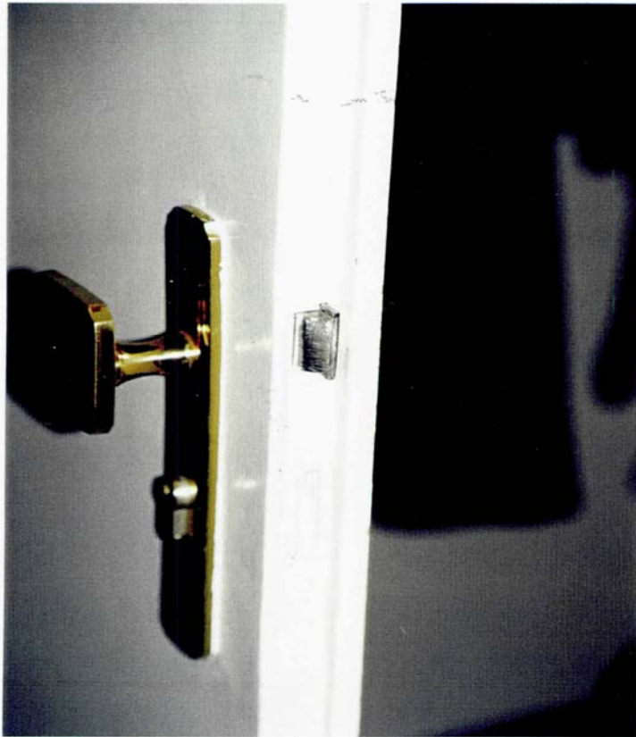
Bild 31 Flurtüre Pacellistr. 8, vorstehender Zylinder
