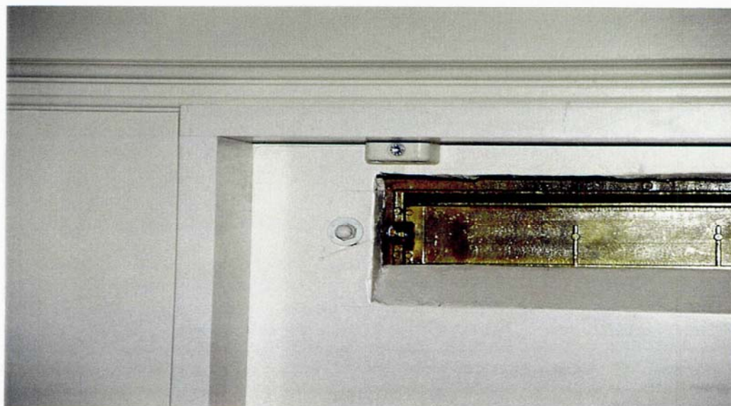
Bild 32 Flurtüre Pacellistr. 8, Briefschlitz
